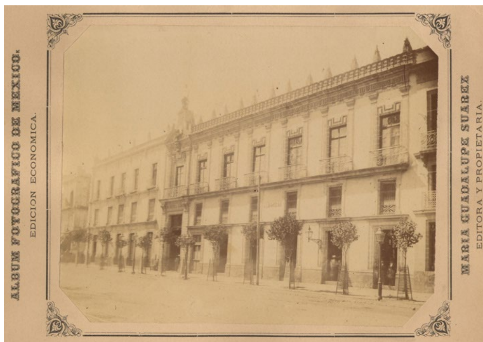
Figuras 19 y 20. Vistas del Nacional Monte de Piedad y registro actual
