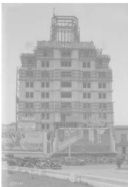
Imagen 36: Construcción del edificio de La Nacional , 1931. AMR, clasif. MR-1551-N
