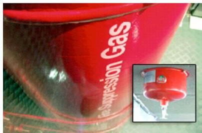
Sistema de supresión de incendio con gas halón en las bóvedas Hollywood, Ca. Cortesía Hollywood Vaults.
