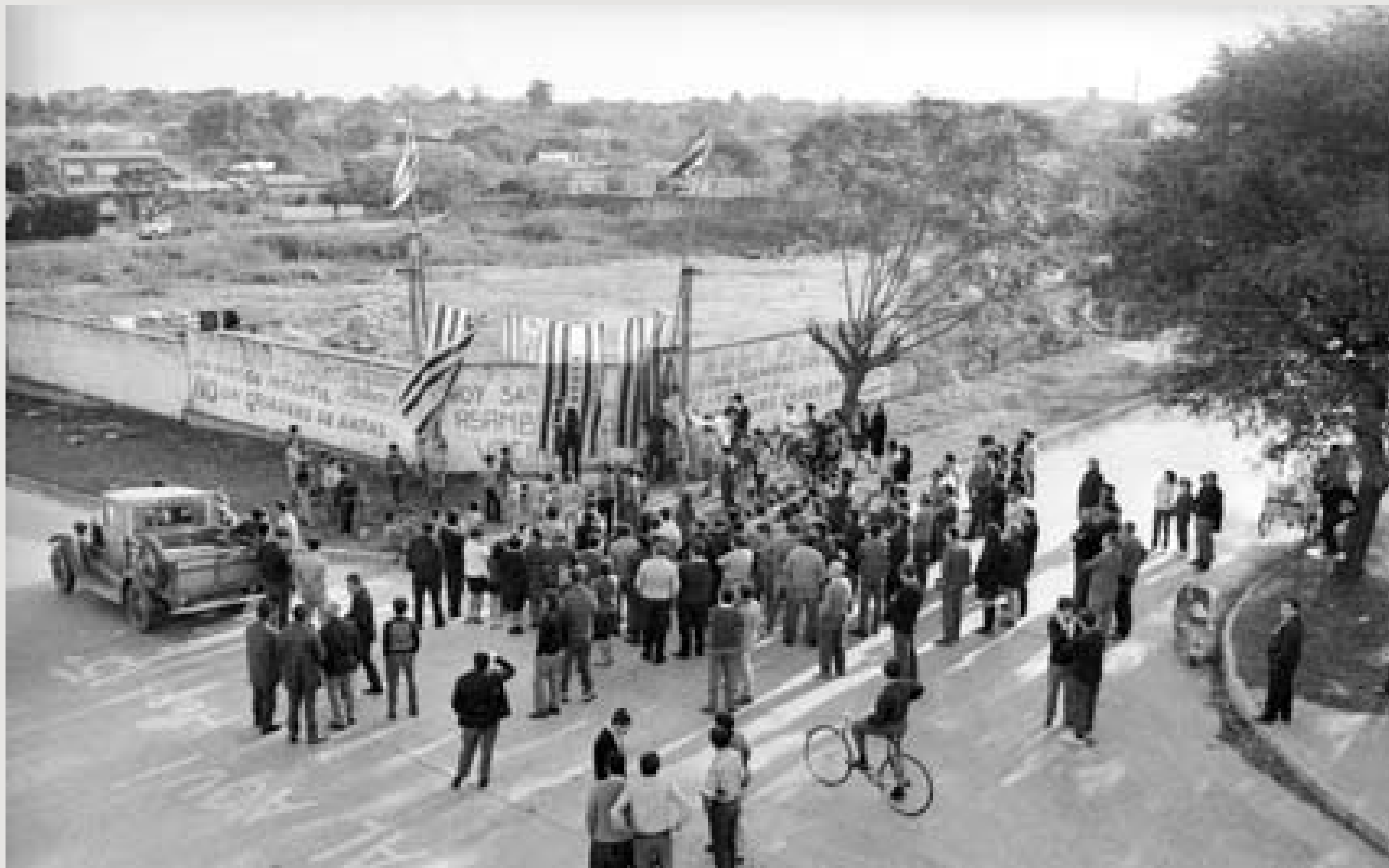
Ocupación de una cantera inactiva. Predio ubicado entre las calles Emilio Romero, P.C. Bauzá, Martín Berinduague y V. Yáñez Pinzón. Año 1969. Negativo de gelatina y plata sobre plástico. 35 mm. Casa de Mario. Foto: n0029_24A-53 - Autor: Mario W. Benabbi.
