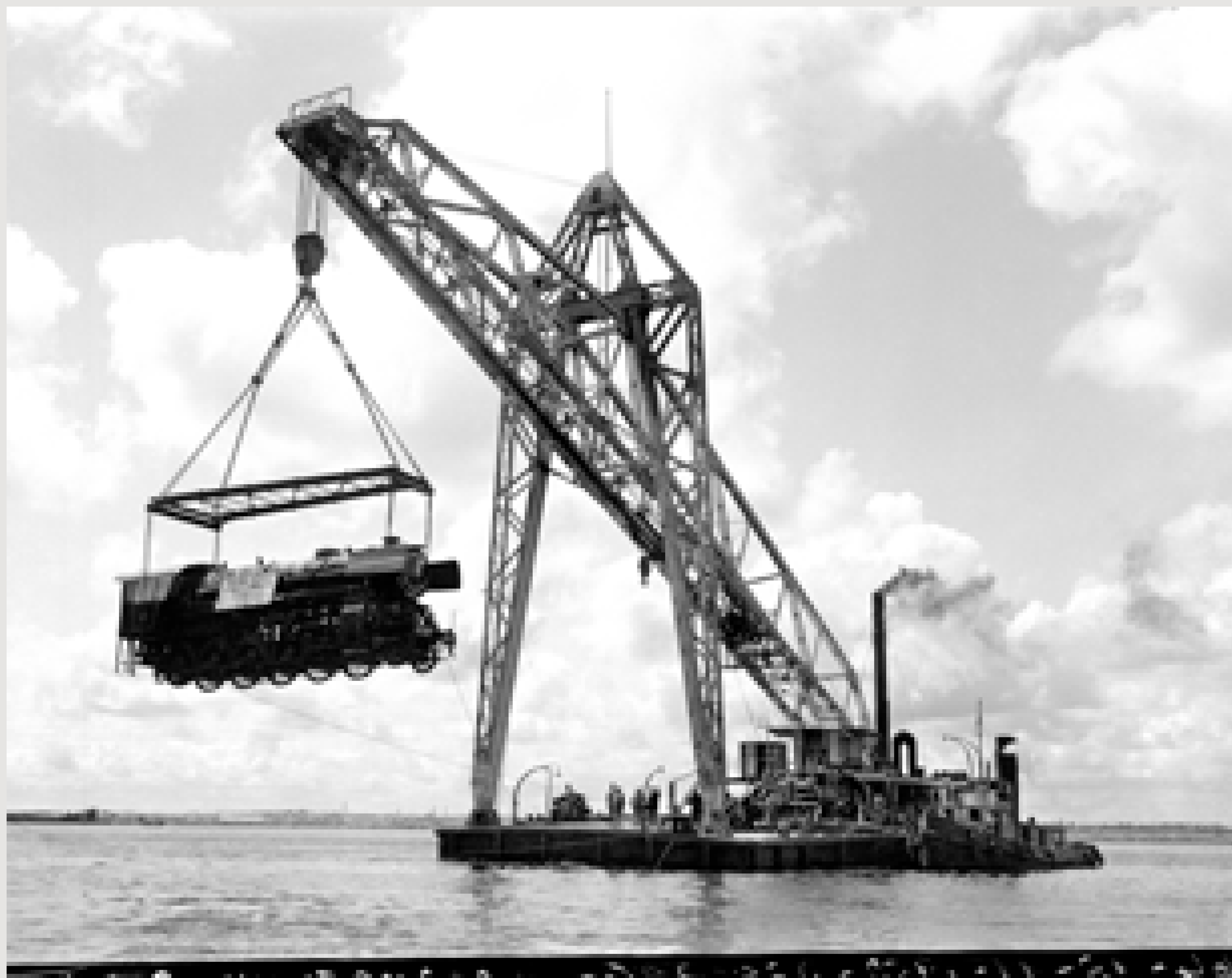
Grúa flotante con locomotora para el FCC Transportain. S.l. 15 de noviembre de 1950. Negativo de gelatina y plata sobre vidrio. Administración Nacional de Puertos (ANP).
