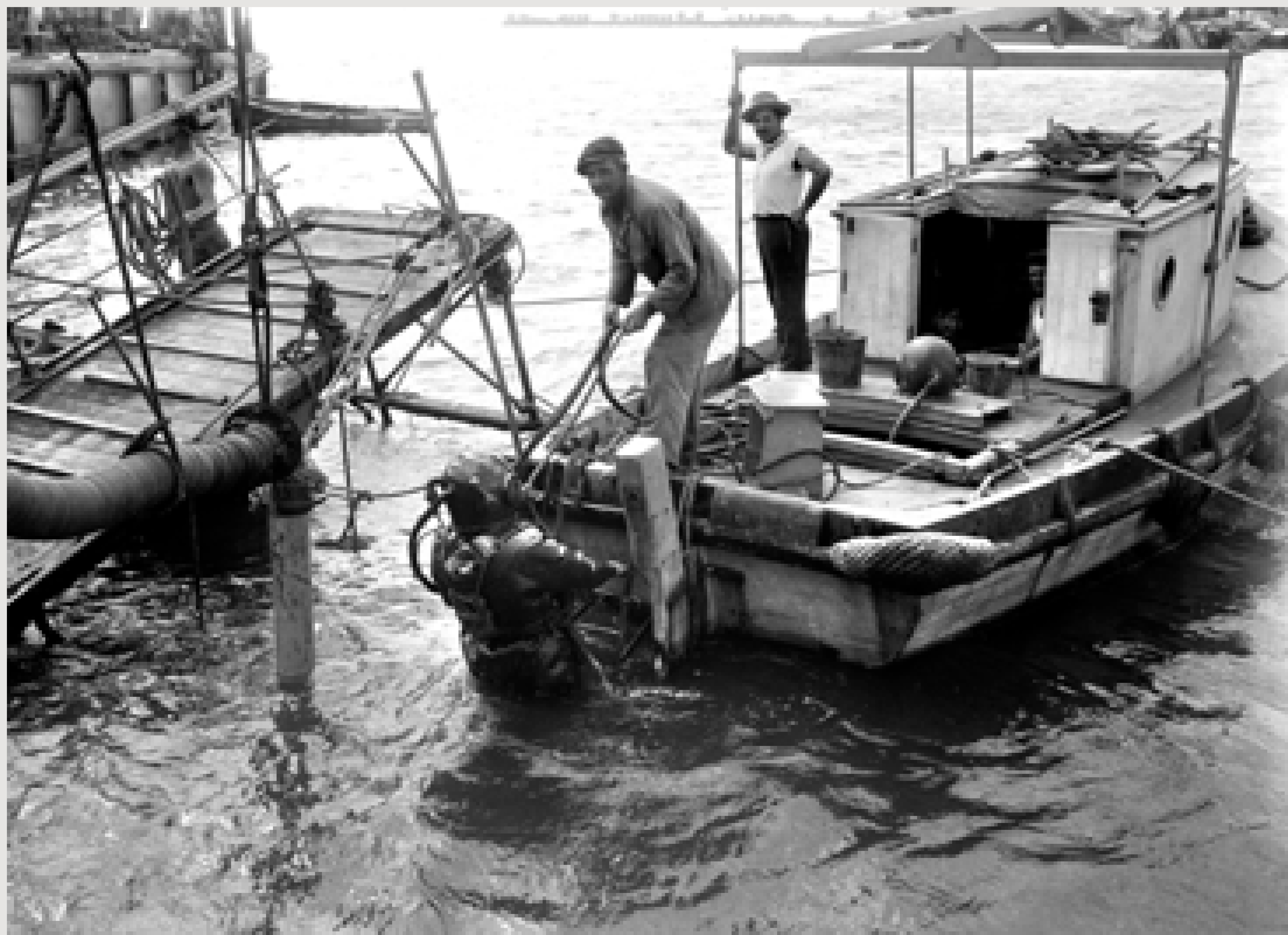
S.I. Lancha proveedora de aire para buzos, durante trabajos para el retiro de un vapor hundido. S.I. 17 de marzo de 1950. Negativo de gelatina y plata sobre vidrio. Administración Nacional de Puertos (ANP). Foto: 828 - Autor: Santángelo/ANP.
