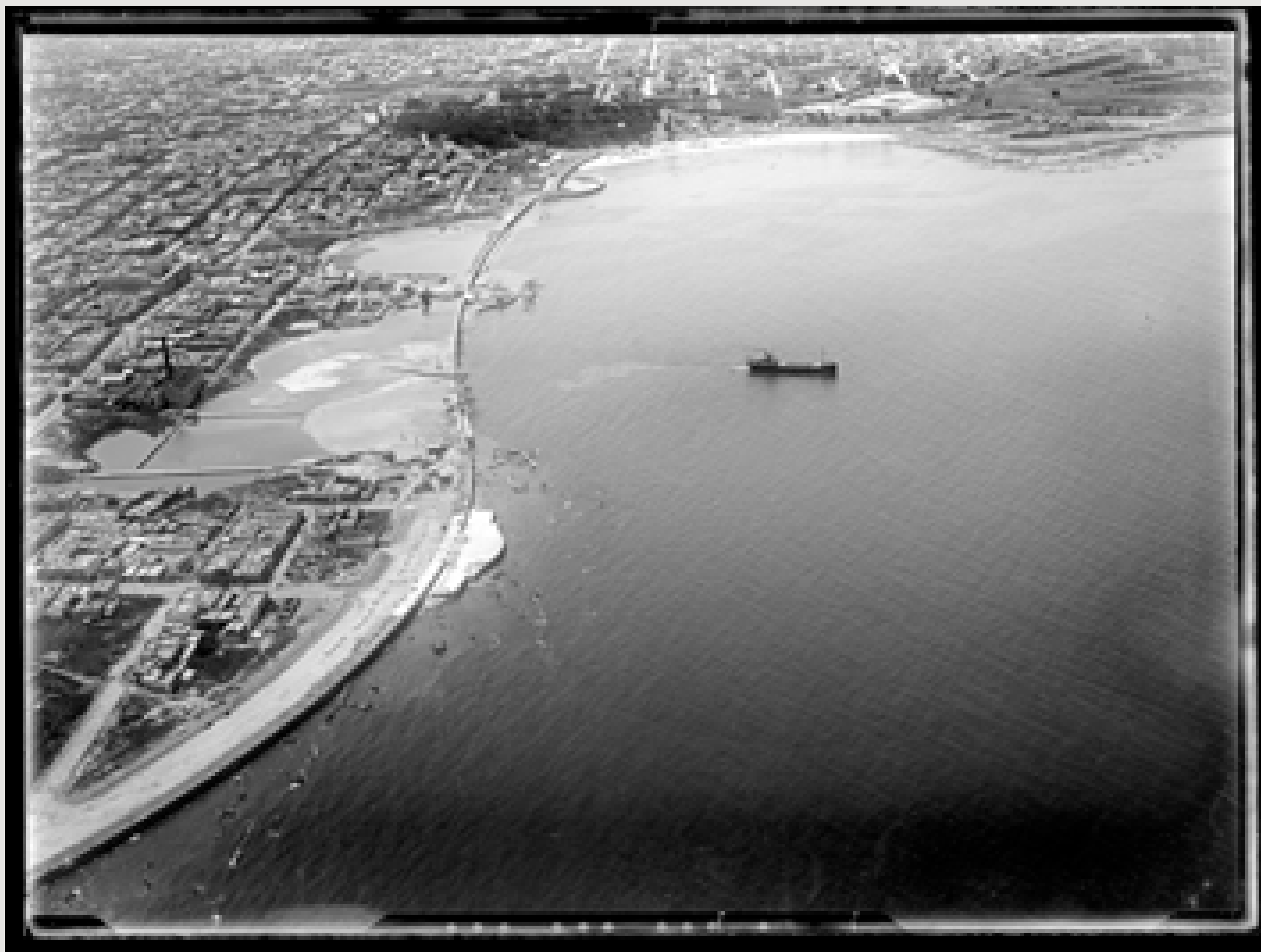
Vista aérea de las playas de Patricio y Santa Ana durante las obras de drenaje y relleno para la construcción de la Rambla Sur. Año 1930. Negativo de gelatina y plata sobre vidrio. 18 x 24 cm. Centro de Fotografía de Montevideo: Foto: 0174FMHB.CDF.IMO.UY - Autor: s.d./IMO.
