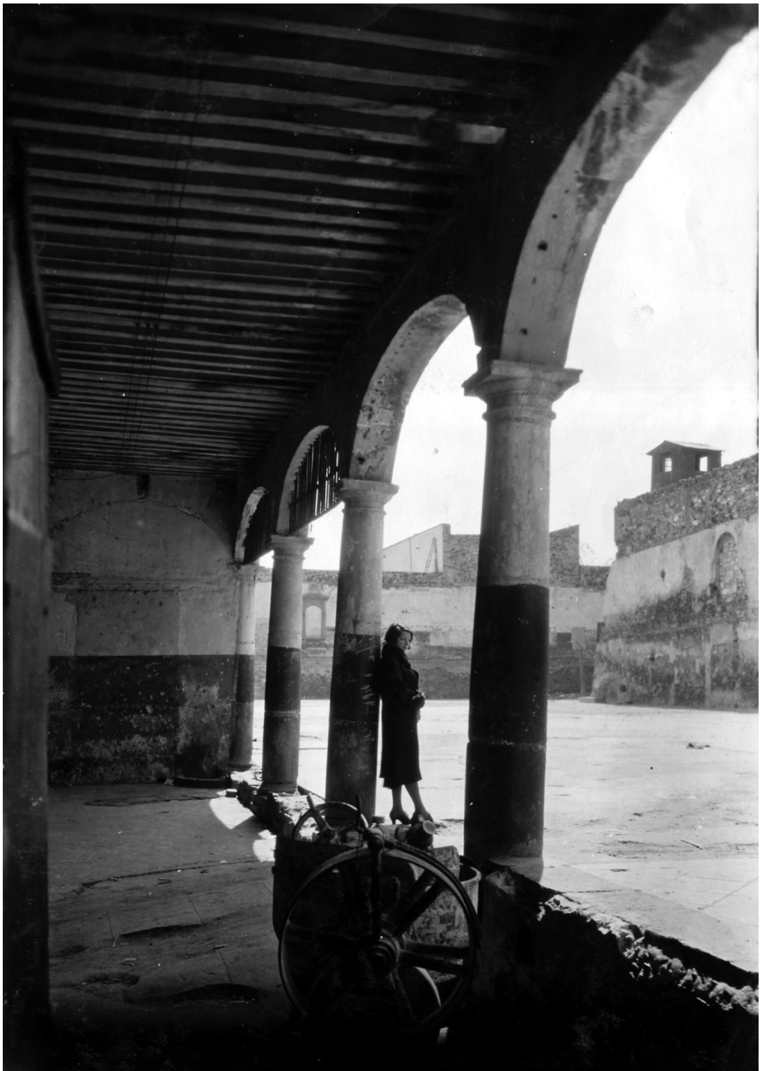
Cárcel General (demolida) Número de catálogo 1491
