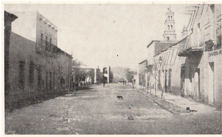
Fig. 2: Vista de la calle de la Botica antigua, c. 1880 La galería se ubicó en el edificio que coincide con la torre de la parroquia. Imagen tomada de Lozano, 1959.
